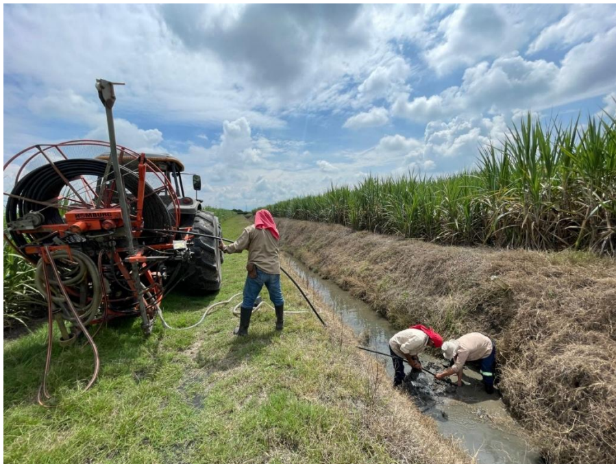
PERSONAL DE AGROGUACHAL REALIZANDO LIMPIEZA DE DRENAJES ENTUBADOS
